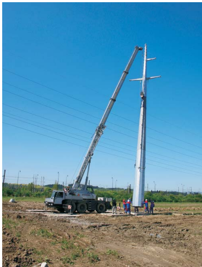
Zakladanie stožiara do základov
