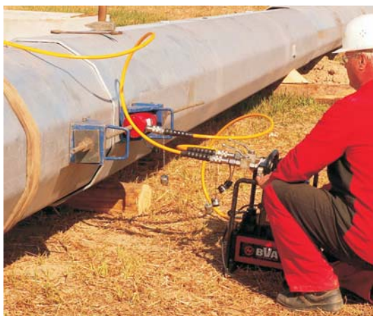
Hydraulické nasúvanie
