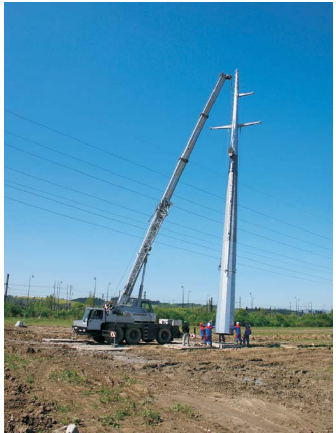
Zakladanie stožiara do základov
